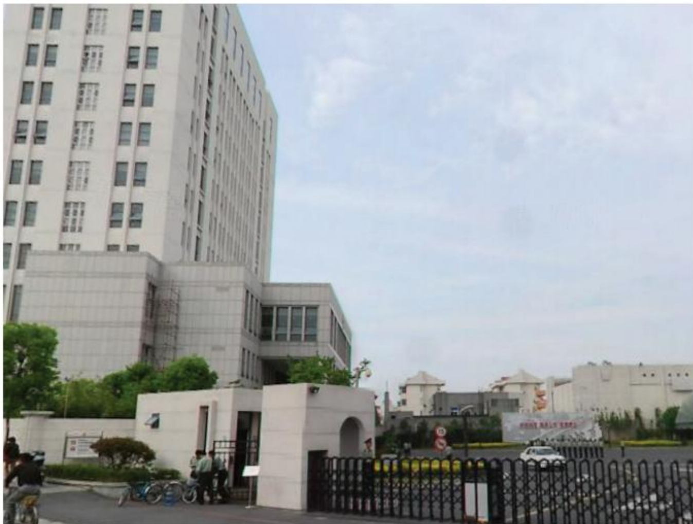
Рис. Главное здание блока (центральный вход).
